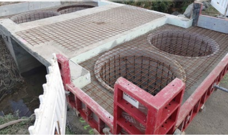
Unterkonstruktion für die Behelfsbrücke
