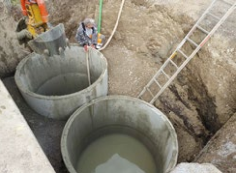
Unterkonstruktion für die Behelfsbrücke
