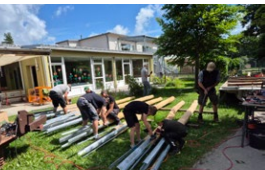
Vorbereitungen der Grundpfeiler des Klettergerüsts
