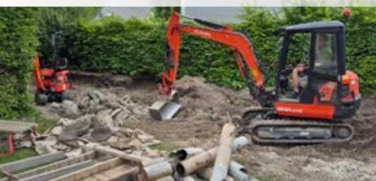
Abbauarbeiten des alten Klettergerüsts durch den Bauhof
