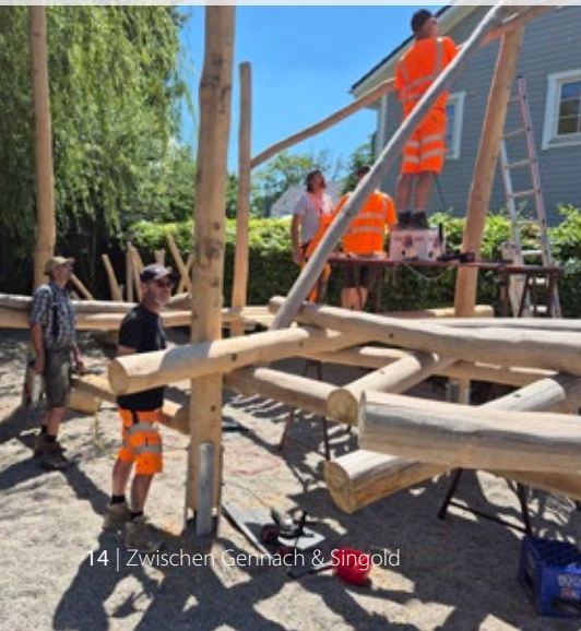
Tatkräftiger Einsatz der Bauhofmitarbeiter
