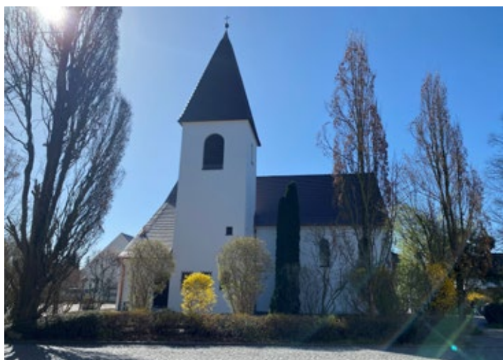
Die fertig sanierte Hoffnungskirche in Buchloe
