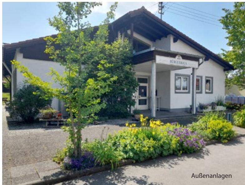
Installation der PV-Anlage
