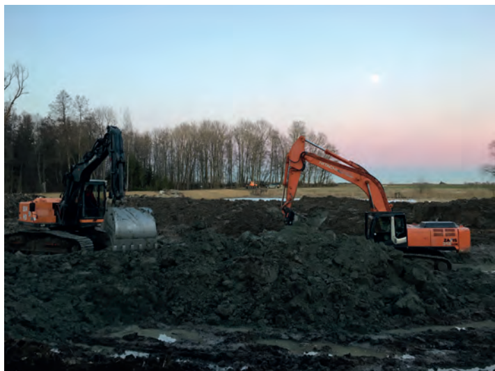
Erdarbeiten am Kitzighofener Weiher mit ortsansässigen Bauunternehmen
